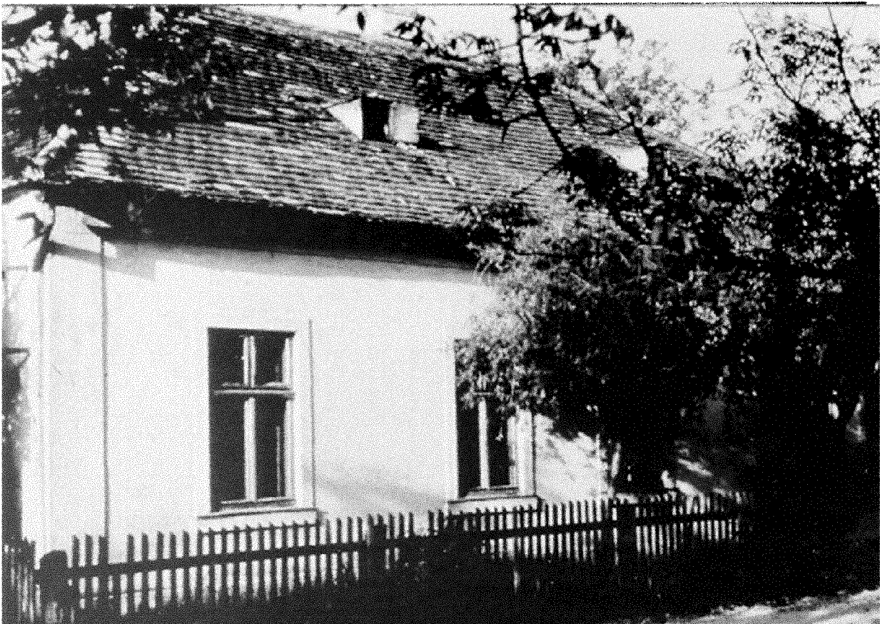
Wohnung der Familie Steiner im Stationsgebäude von Pottschach
